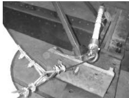
Figuur 43: knooppunt randkabels.
