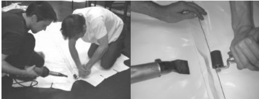
Figuur 39 : lassen van het membraan.
